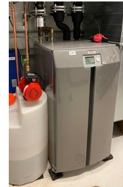
Heat pump (HP) Gebwell T2 32 kW (Kuosa 2021, Xamk)
