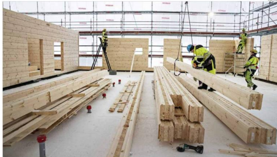
Kaislastenlahden koulun hirsiseinät nousevat vauhdilla säältä suojassa.
