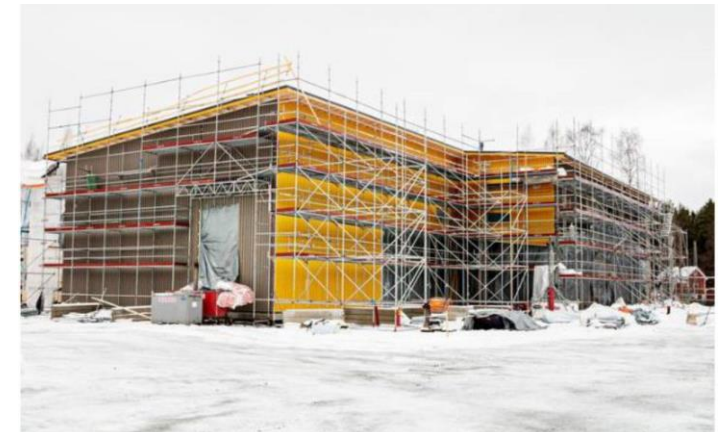
Kaislastenlahden hirsikoulu valmistuu katseilta piilossa. Kuva: Tuire Punkki
